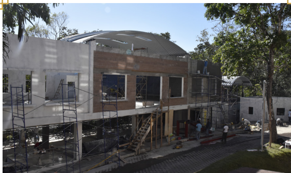
Construcción del primer Food Court UEES.
