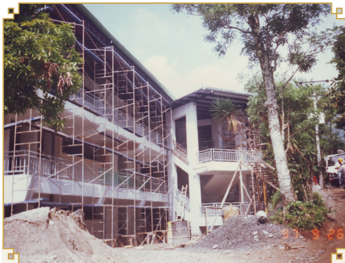
Construcción del Edificio 1 en el campus situado sobre la prolongación alameda Juan Pablo II, calle El Carmen, San Antonio Abad.
